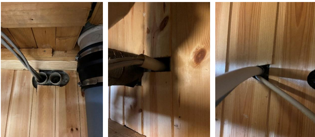
Figur B – Kortare plaströr för kabeldragning
