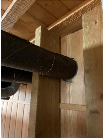
Figur C – Obrännbart rör med isolering
